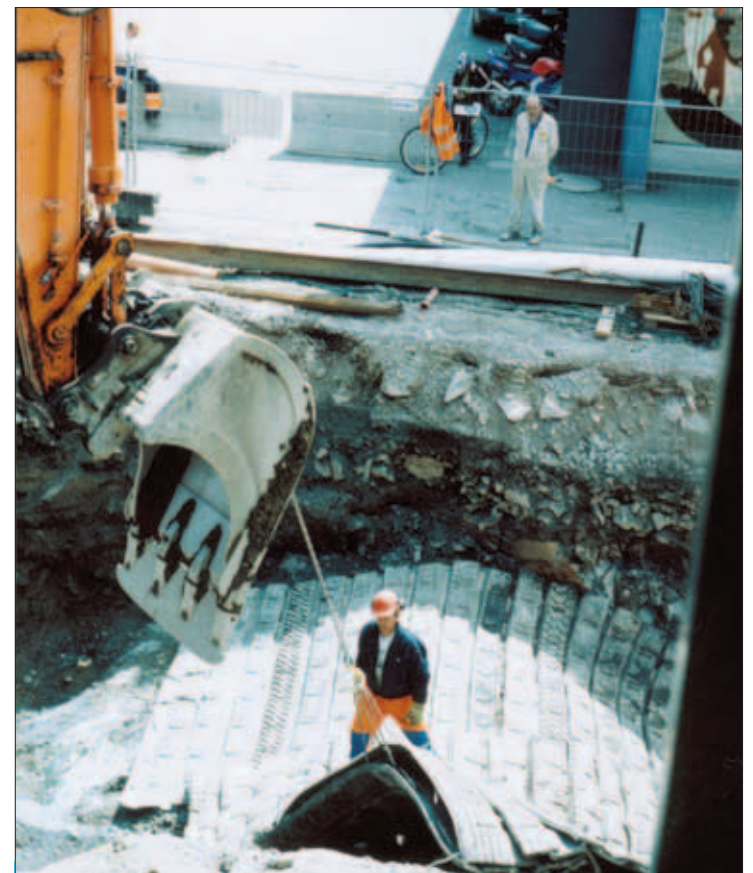
GRØFTEGRAVING: Mer graving i Asker hvis Bio Varme Akershus får fjernvarmekonsesjon og skal legge vannrør i 9 kilometer med grøft. FOTO: ASKERDAGEN
